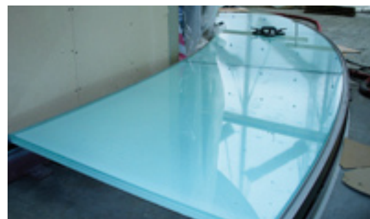
Ananasformet gå-på-glas, 3 x 12 mm lamineret float
