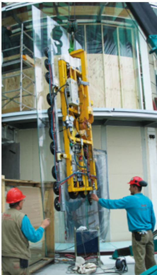
Ananasformet gå-på-glas, 3 x 12 mm lamineret float
