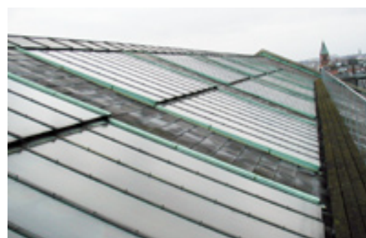
Københavns Hovedbanegård – renovering af glas i tag over forhal
